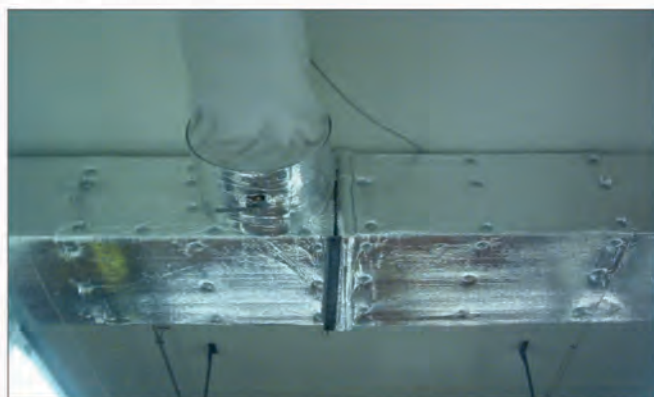
Astro-Foil isolasjon på tilluftskanal
